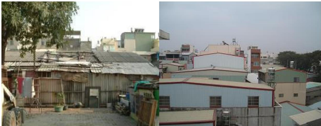
圖 4 新草衙建築擁擠、巷道狹小或未臨接道路
