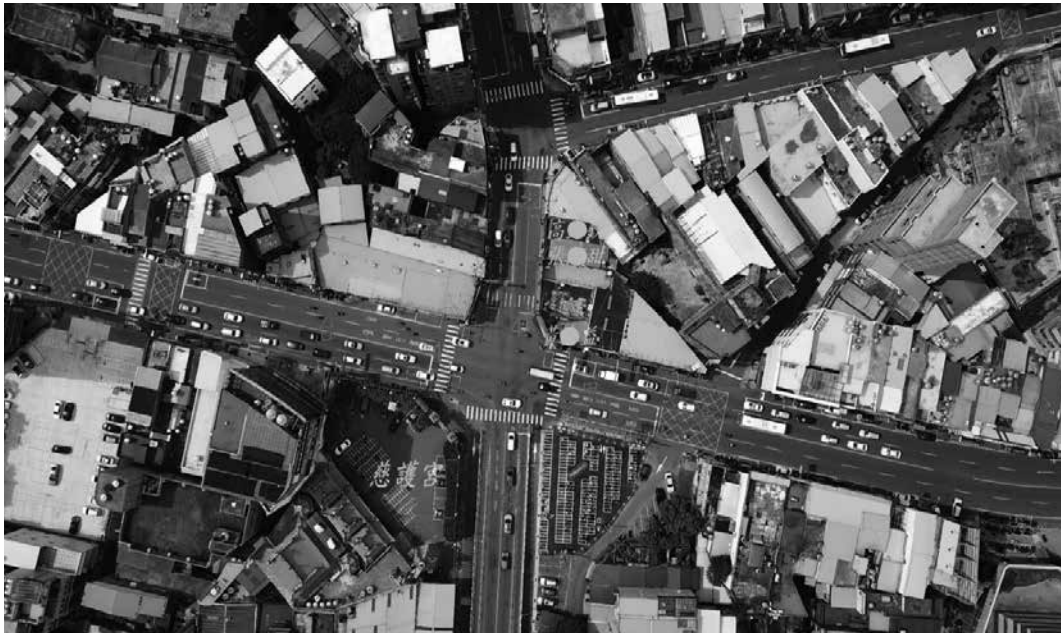
圖 3 省道臺 1 甲線與臺 4 線交叉路口航照圖
