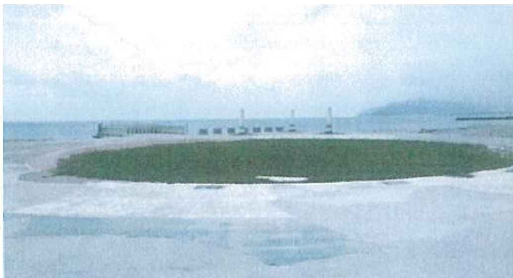
照片 6 北濱海岸舊漁村休閒設施完工後尚無法補辦建築執照之閒置現況
