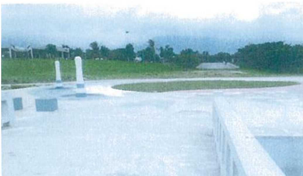
照片 5 北濱海岸舊漁村休閒設施完工後尚無法補辦建築執照之閒置現況
